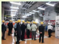
平成30年度 みなとみらい21熱供給第2プラント
