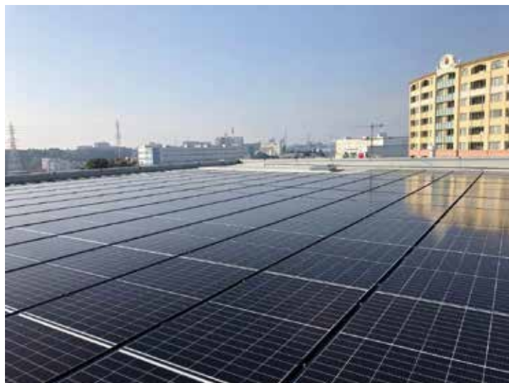
2020年11月 本社の屋根に太陽光パネルを設置しました。
