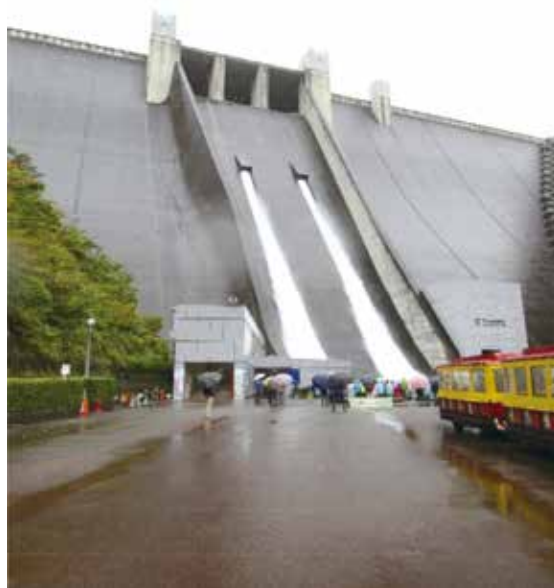
宮ヶ瀬ダム放流
